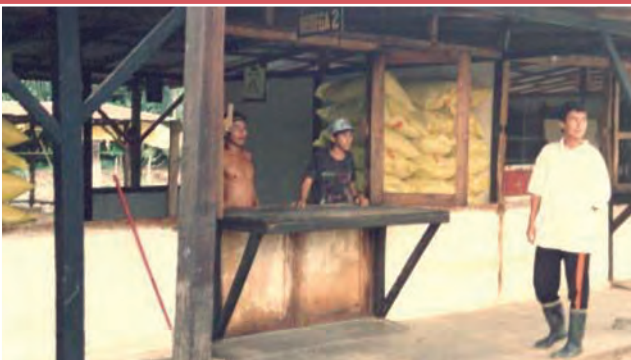
Imagen No. 19-TMA. Bodega debidamente diseñada.
