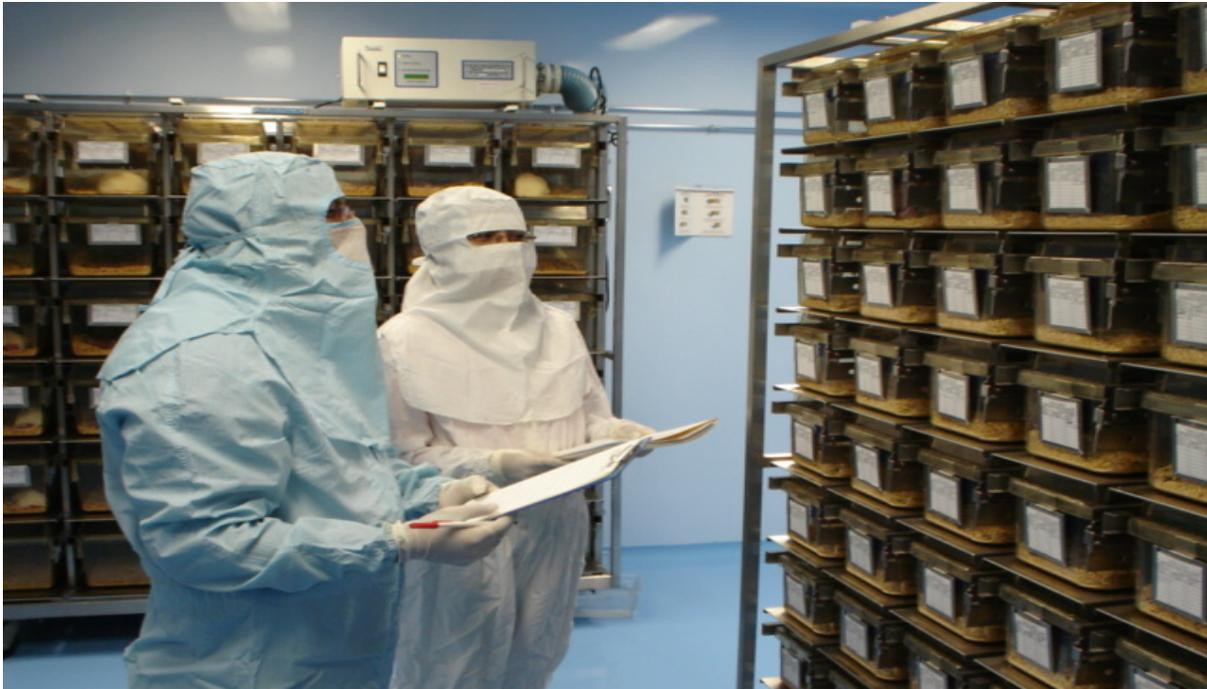
**Figura 4.** Sistemas integrales ventilados para el alojamiento de roedores que poseen sistemas de filtración HEPA independientes en cada jaula y mantienen 70 cambios de aire por hora (foto UAM-X).
