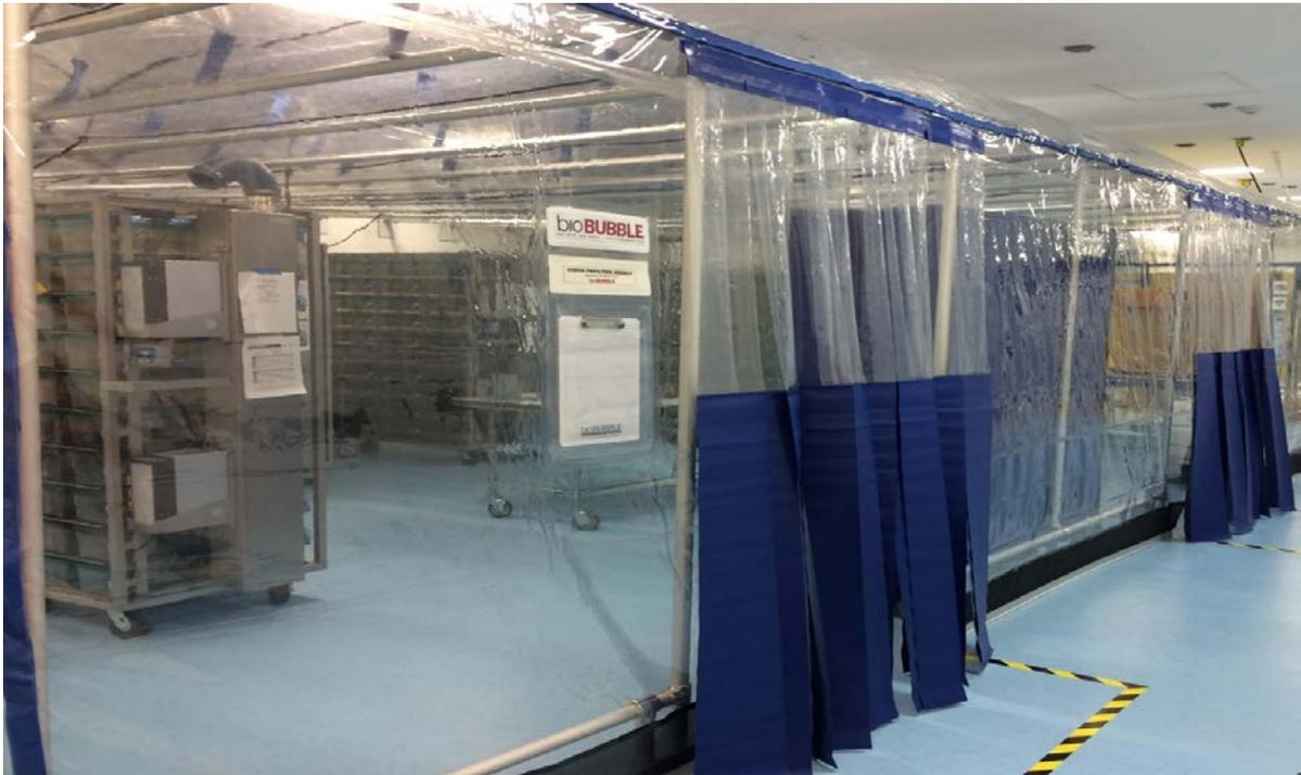
**Figura 7.** Diseño de un sistema que integra tecnológicamente el edificio, cuartos limpios y estantes ventilados que en su conjunto garantizan el alojamiento de roedores de laboratorio en las mejores condiciones macro y micro ambientales conocidas. Foto cortesía del CINVESTAV (2014).
