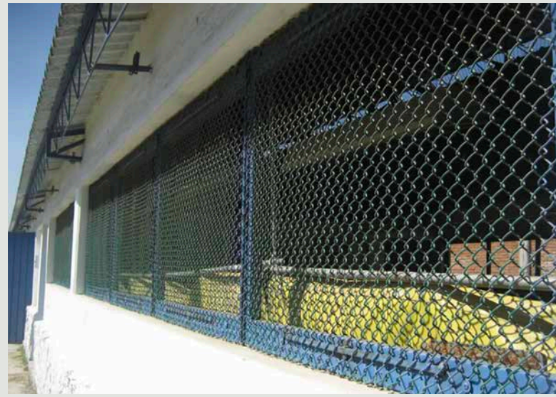
FIG. 1. Malla protectora en ventanas de una nave de conejos.
