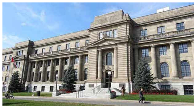
AVIVAGEN INC. EN CANADA SUS OFICINAS CENTRALES.
