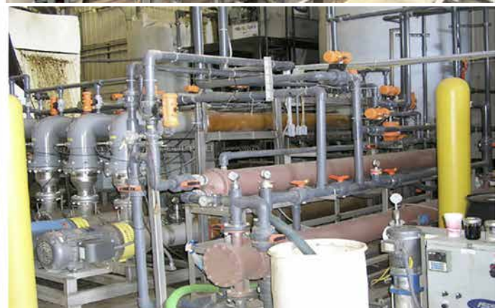
Flotación de aire para separar líquidos de sólidos. Tratamiento de aguas casi potable. Ultrafiltración. Super filtrado con ósmosis inversa.
